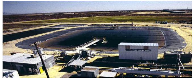
Figure 4 : El Paso Solar Pond, Texas, USA (Brown 2002)
