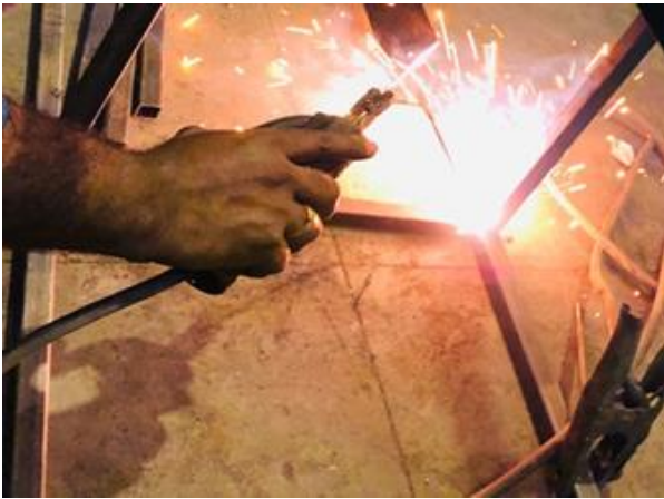
Fig: 3.6. Arc welding
